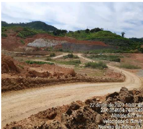
Foto 11 - Canteiro de obras da Barragem (Data: 22/01/2021).
