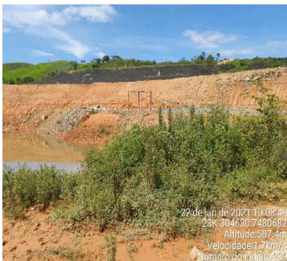
Foto 9 - Canteiro de obras da Barragem (Data: 22/01/2021).
