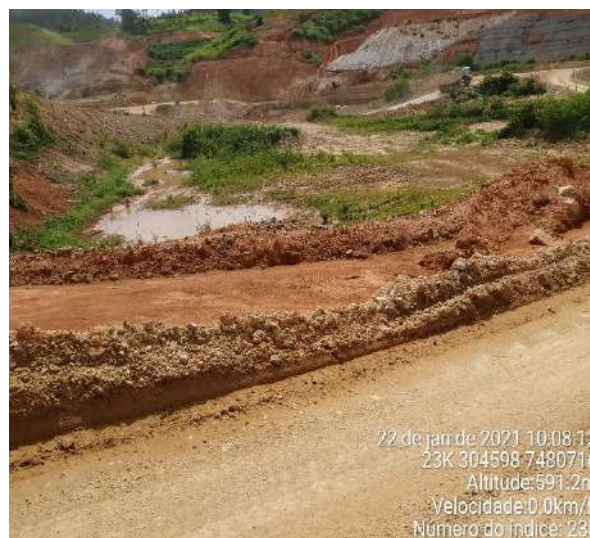
Foto 10 - Canteiro de obras da Barragem (Data: 22/01/2021).
