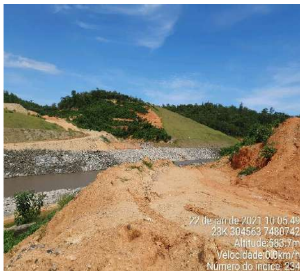
Foto 12 - Canteiro de obras da Barragem (Data: 22/01/2021).
